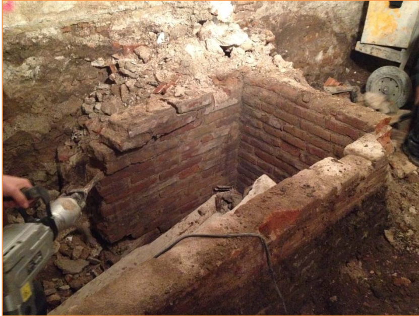
Foto 17. UE 17, treballs de desmuntatge del dipòsit.
