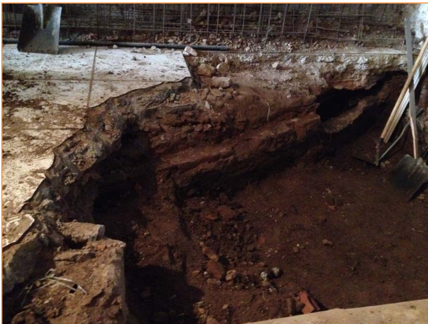
Foto 14. UE 12, estat inicial.
