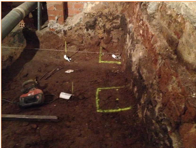
Foto 12. Marcatge dels pilars per col·locar les bigues metàl·liques.
