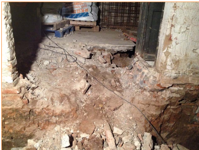
Foto 9. UE 1, treballs d'enderroc en la zona entre locals.
