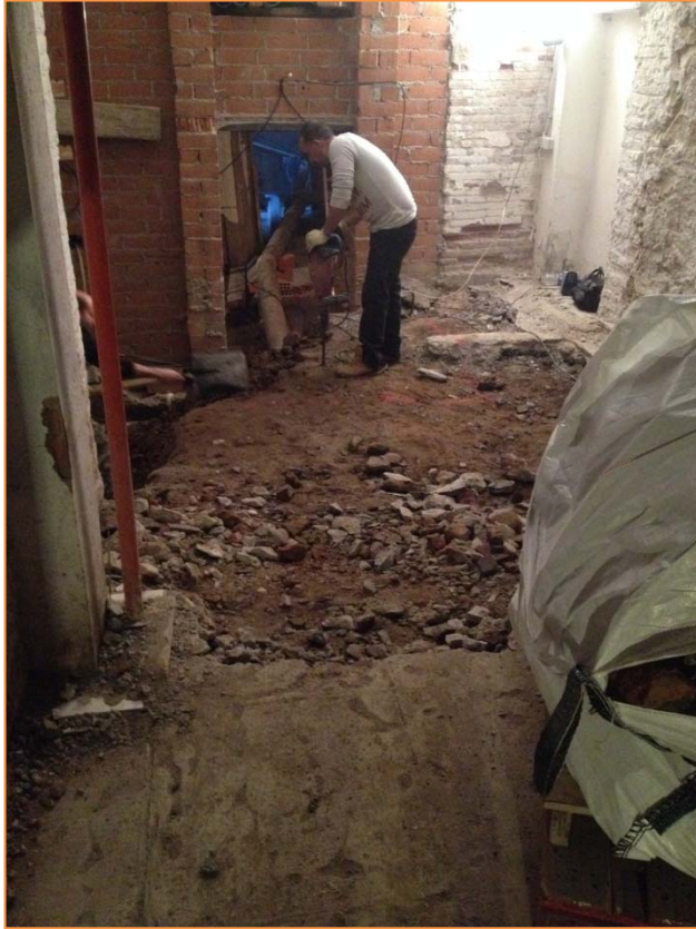
Foto 1. Inici dels treballs en el sondeig 1.
