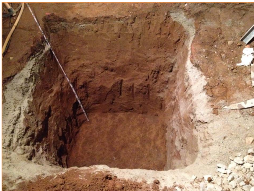
Foto 5. Estat final del sondeig 2, banda sud.
