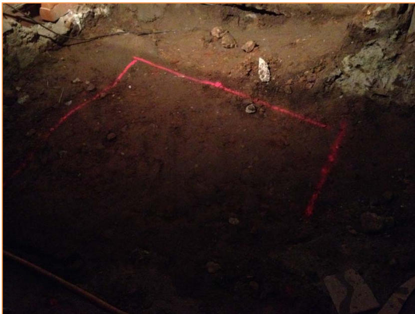
Foto 4. Inici dels treballs en el sondeig 2.
